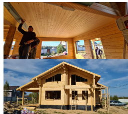
Чеховский район, перекрытия
